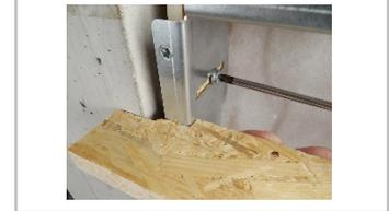
3. Einbaurahmen mit den 4 Sicherungsschrauben sichern.
